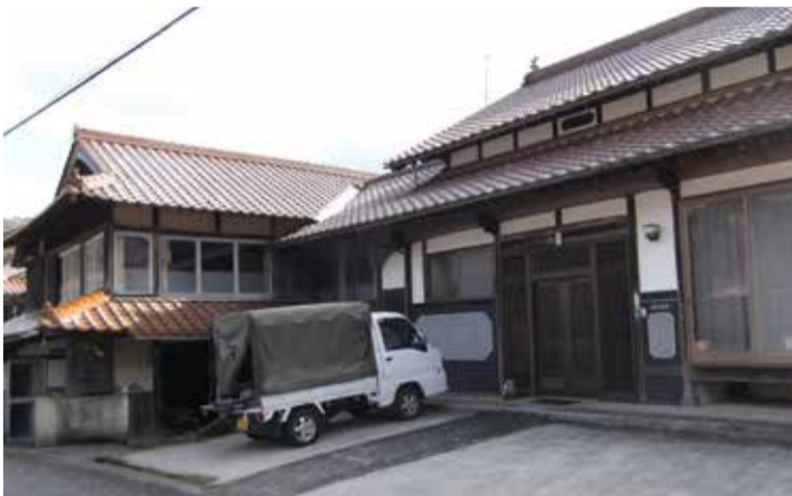
田屋の外観。右の母屋が交流施設、左の納屋を加工場に改築中
