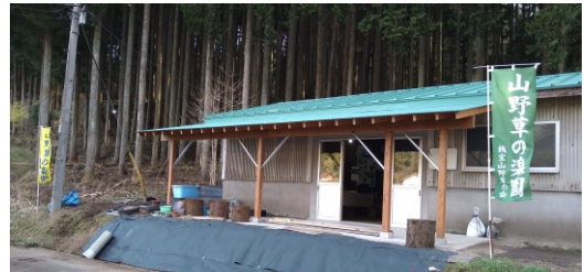
改修後の管理棟
