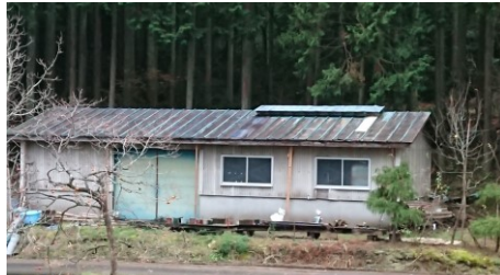
改修前の管理棟
